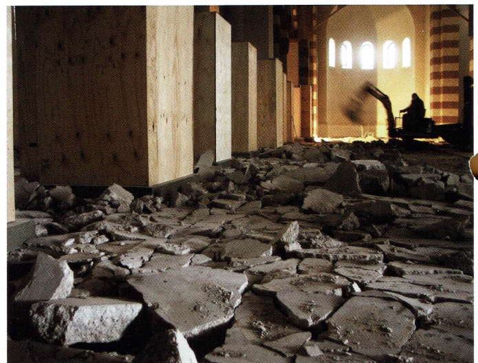
Aufbruch des Betonfußbodens, 2006
