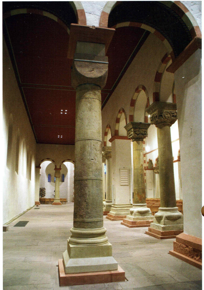
Nördliches Seitenschiff/Westliches Querhaus: Säule mit CFK-Bänderolensicherung
