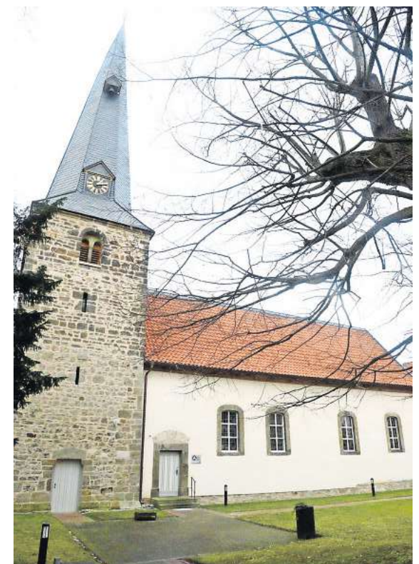
Mittlerweile abgehakt – die äußere Instandsetzung der Kirche in Grasdorf.
