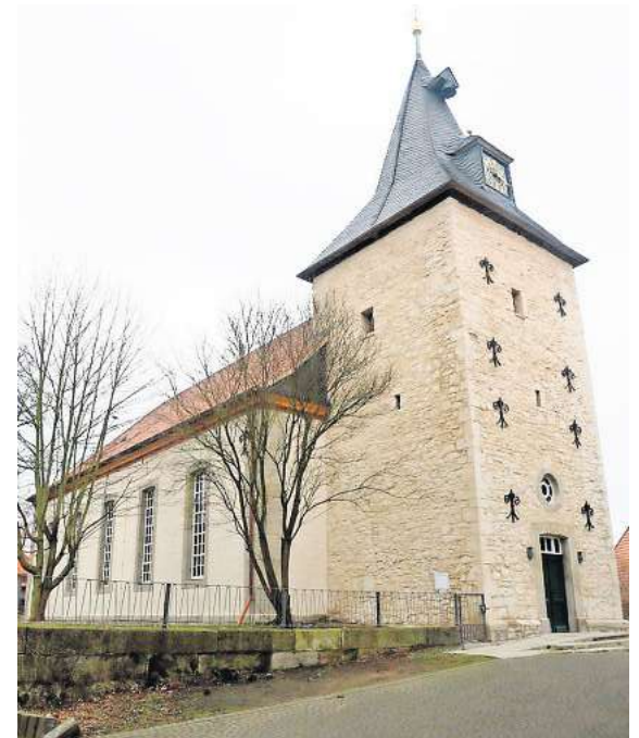
Vor dem Abschluss stehen die Arbeiten an der Kirche St. Georg in Freden.
