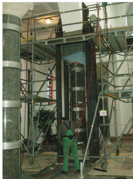
Bild 17. Absturzsicherung Kirche St. Josef, Mannheim Fig. 17. Fall arresting device (safety stiffening) at St. Josef church in Mannheim
