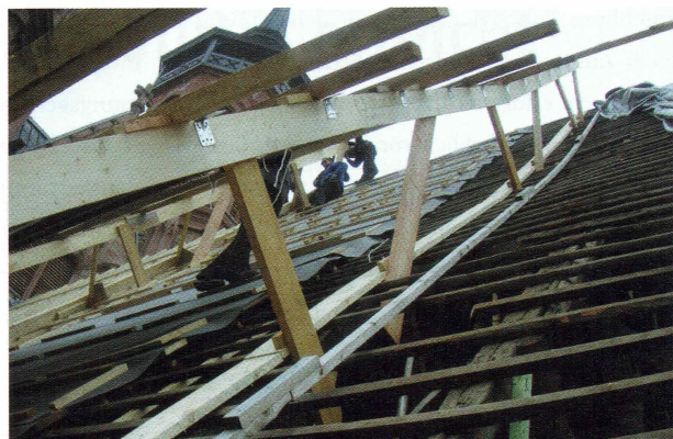
Bild 8 Aufbringen des Schutzdaches
