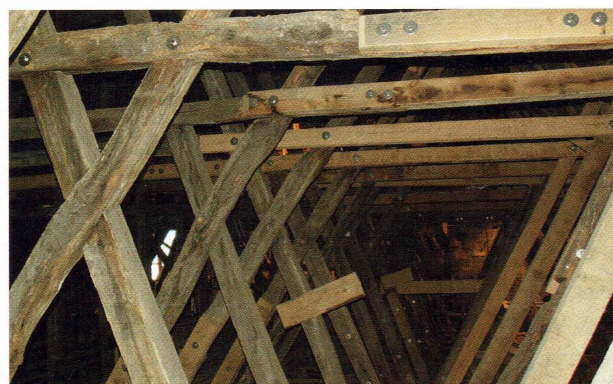
Bild 10 Blick in das sanierte 5-geschossige Kehrlriegeldach (hier unteres, inneres Strebenwerk)
